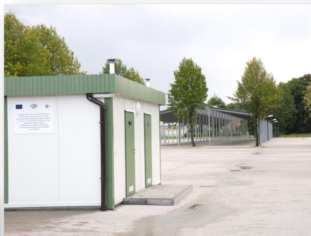
Modernizacja świetlicy wiejskiej w Laskach
